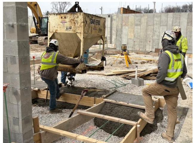
Final concrete footing pour of Area C!
